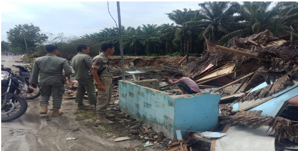
Gambar 6 :Pembongkaran Kios di Kawasan Kek Sei Mangkei oleh Tim Satpol PP Kab. Simalungun
