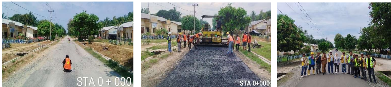
Foto Penanganan Long Segment Jalan Jurusan Damak Kitang - Silau Dunia Kec. Silou Kahean
