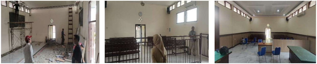
Foto Rehabilitasi Kantor Pengadilan Negeri Simalungun
