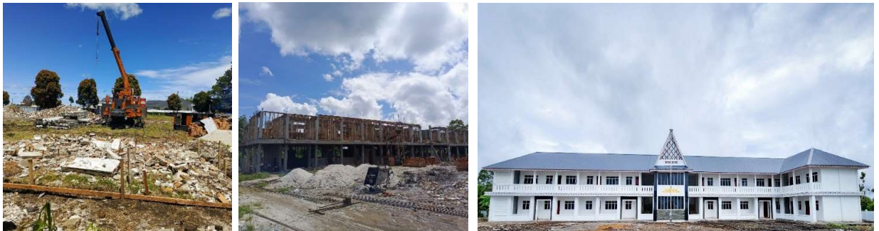
Foto Pembangunan Gedung SDN Tigarunggu Kec. Purba
