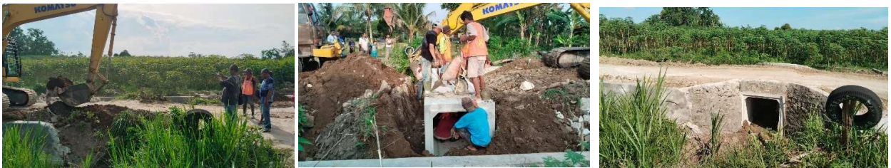
Foto Penanganan Long Segment Jalan Jurusan Rambung Merah - Karang Rejo Kec. Siantar / Gunung Maligas
