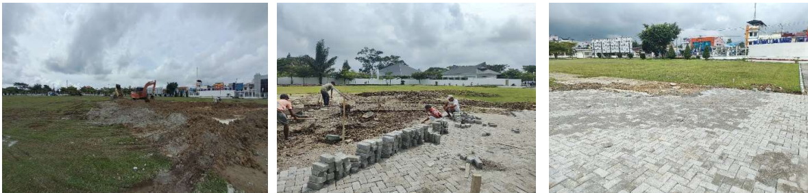
Foto Penataan Lapangan Kantor Bupati Simalungun di Pamatang Raya
