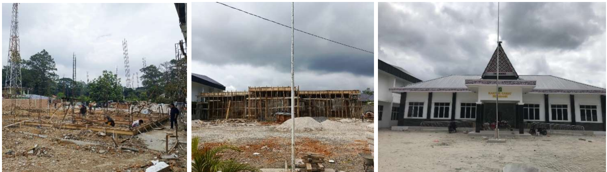
Foto Rehabilitasi Gedung Balai Pertemuan di Sarimatondang Kec. Sidamanik
